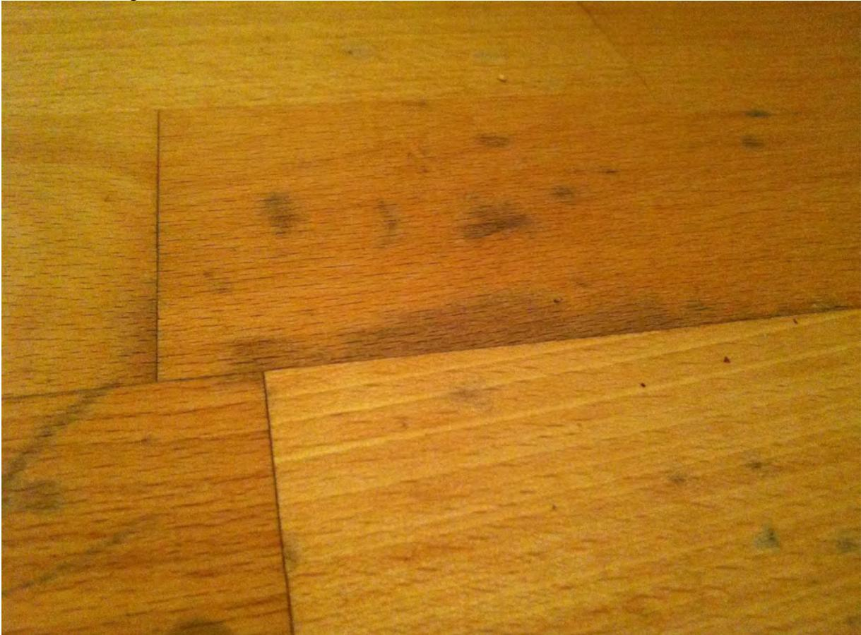
Bild 3: Wasserschäden
