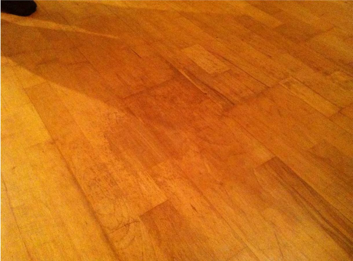
Bild 2: durchgescheuerter Lack
